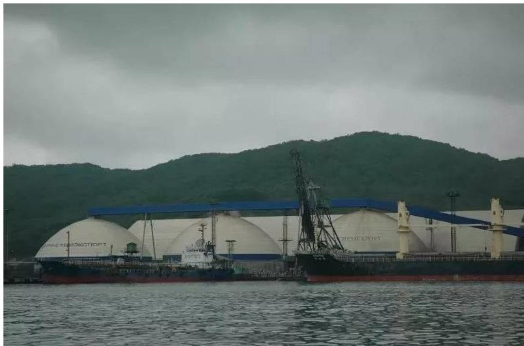
Рисунок 2.5.4 – Куполообразные закрытые склады ООО «Восточно-Уральский терминал» Транспортирование (данные по каждому складу).
