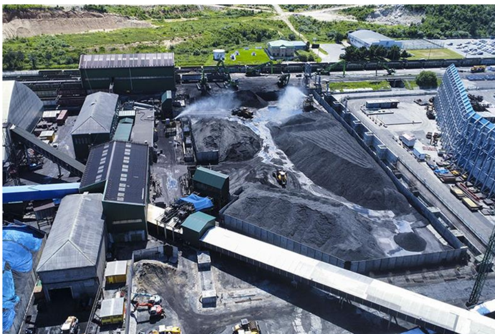
Рисунок 2.3.1 – Общий вид на промплощадку ООО «Восточно-Уральский Терминал»
