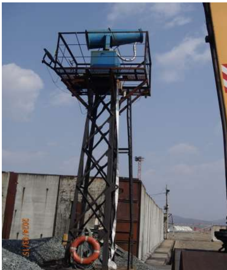
Рисунок 2.5.5 – Работа по пылеподавлению
